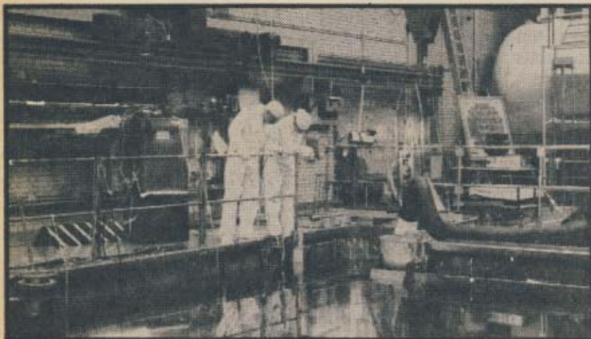
Het verwisselen van de splijtstof.
